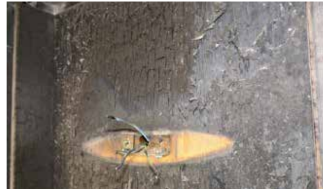
Emplacement de l'halogène qui a déclenché l'incendie
