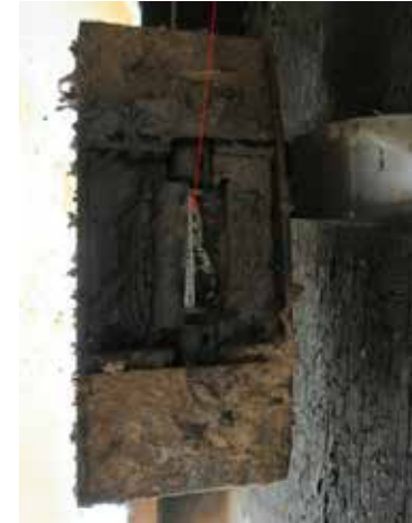
Lampe halogène après extinction de l'incendie
